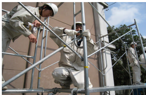
施工実習での足場の組立て
