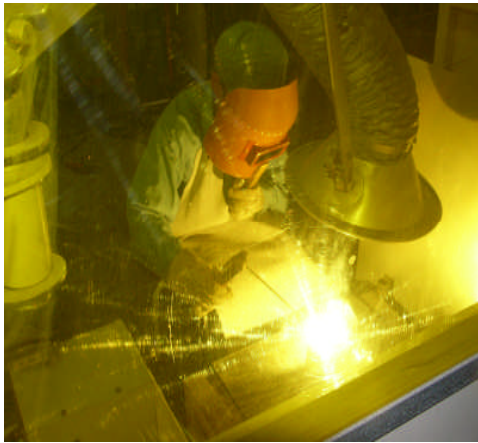
アーク溶接作業
