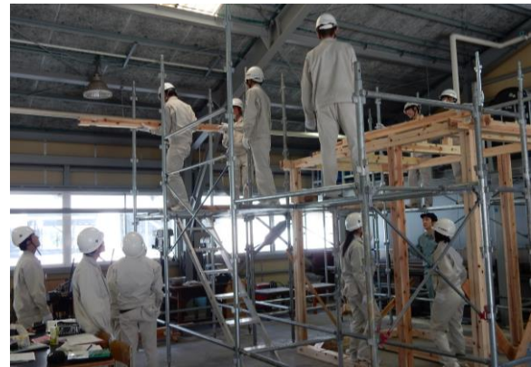
施工実習での足場の組立て
