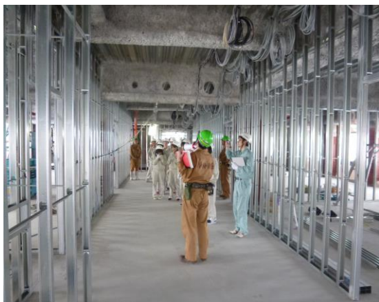
建築実習：現場見学
