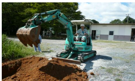
<小型車両系建設機械技士講習>
