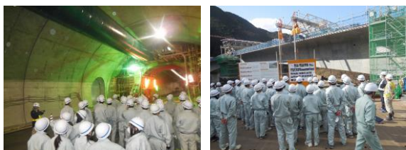
<工事現場見学>
