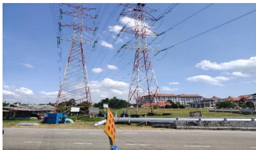
図 13 マレーシアの送電鉄塔
